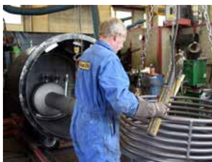
Les échangeurs thermiques, chauffe-eau et les raccords sont soudés.
