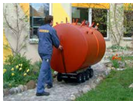
Sur demande: aide pour rentrer l'accumulateur et pose de l'isolation sur le chantier.
