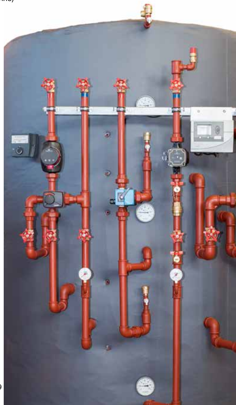
Groupe de chaudière à bois et mazout
