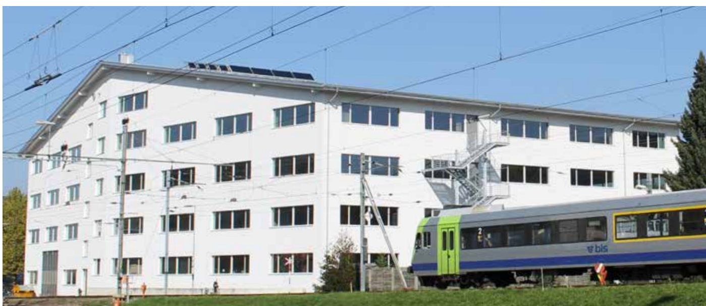
Capacité de production élevée dans notre usine à Oberburg. Plus d'images sur www.jenni.ch .
