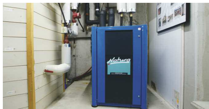
Baubewilligungsfreie Erdwärmesonden-Wärmepumpe
