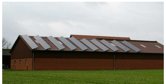
Aufgeständerte Solaranlage (&gt; 20 cm)
