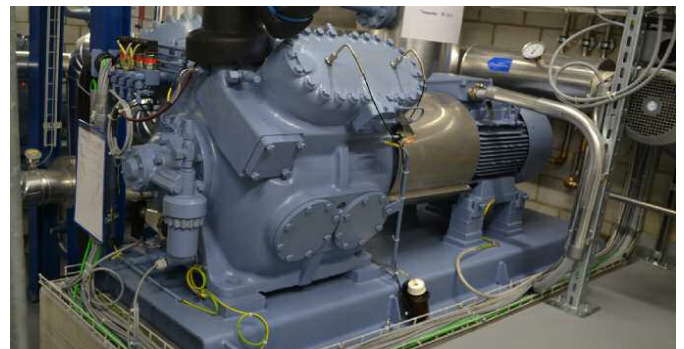
Baubewilligungsfreie Grundwasser-Wärmepumpe
