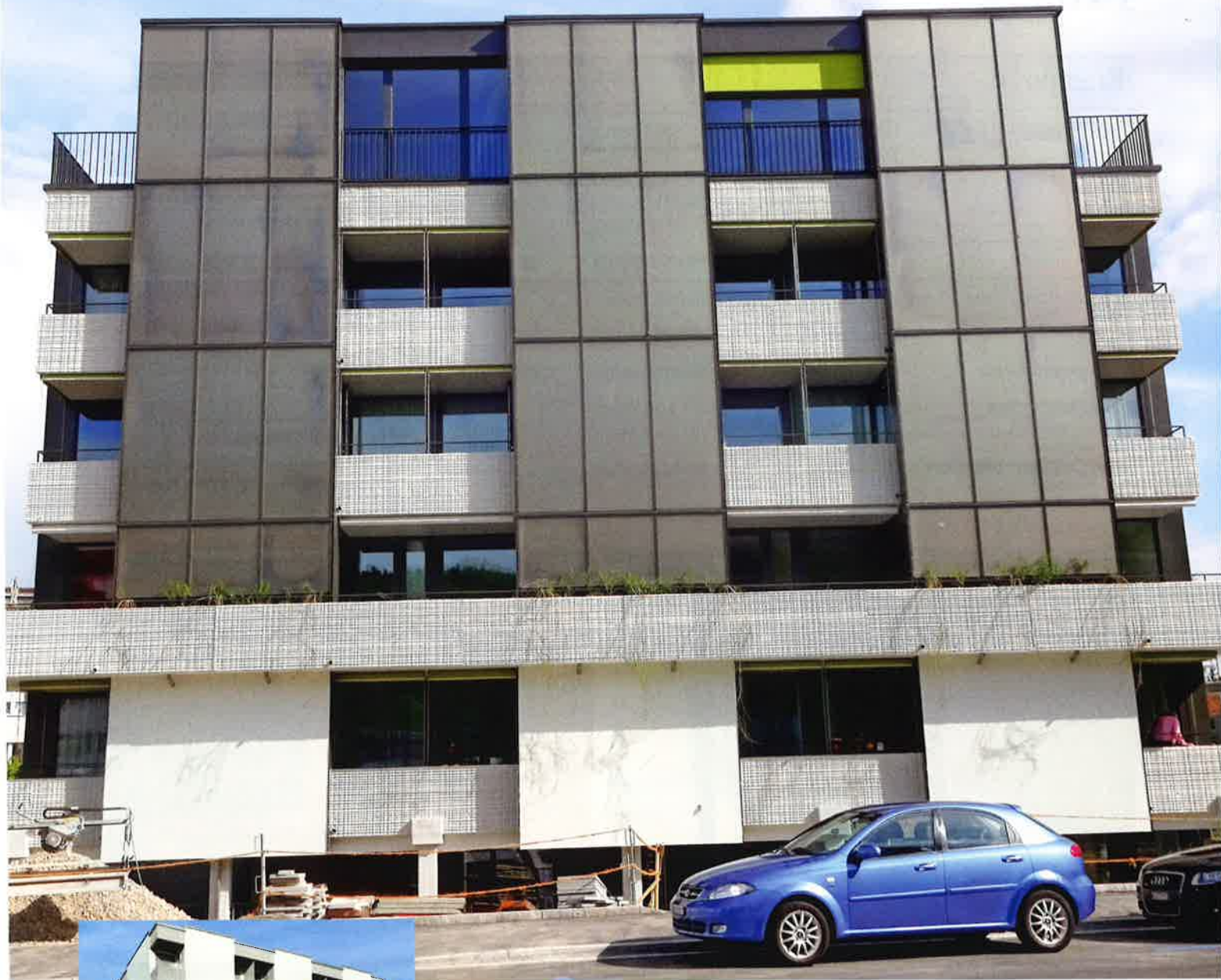
Die südseitigen Sonnenkollektorflächen sind farblich unauffällig und passen sich ideal ins Fassadenbild ein.
