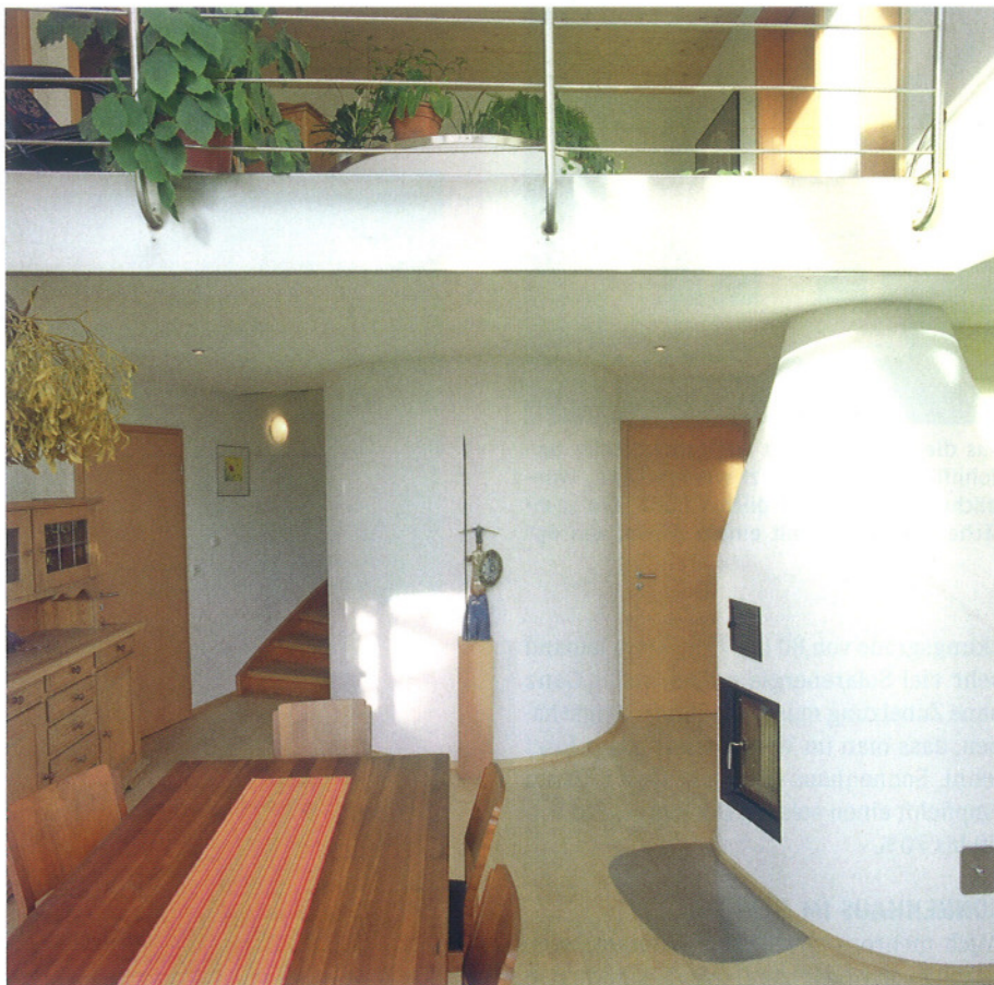
Dieses Einfamilienhaus wird zu etwa 80% solar beheizt. Nach dem Jenni-Konzept soll der Wärmespeicher im Inneren des Hauses stehen. Hier reicht der 5,2 m hohe Speicher (Fassungsvermögen 11 m 3 ) vom Erdgeschoss bis in die erste Etage.
