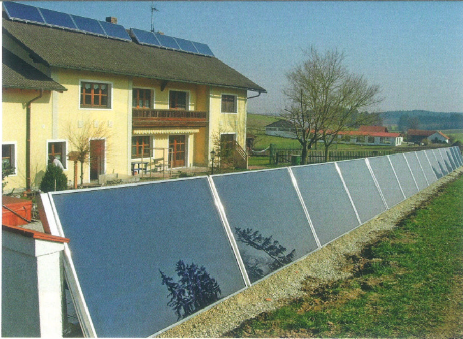
Bei dieser Altbausanierung wollte der Besitzer nicht, dass noch mehr Kollektoren auf sein Dach kommen. Der Heizungsfachbetrieb Schuster Gebäudetechnik fand eine Lösung und installierte die Kollektoren an der Gartenmauer.
