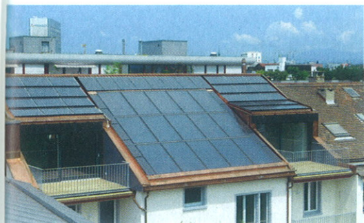
Das Plus stammt von den dachintegrierten Sonnenkollektoren und Photovoltaik-Modulen
