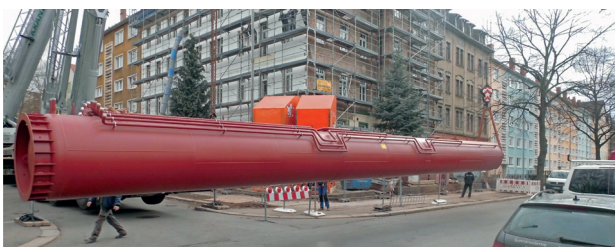
Solarspeicher für Mehrfamilienhäuser in Chemnitz
