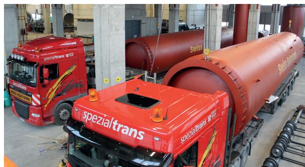
2 Speicher à 82 700 l Inhalt für solarbeheizte MFH in DE-Laufen
