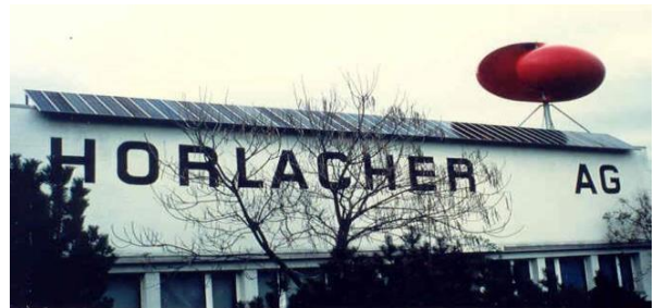
Tour de Sol 87 : Netzgekoppelte PV-Anlage für 5 Tour de Sol-Teilnehmer – der Beginn des Booms der netzgekoppelten PV-Anlagen.
