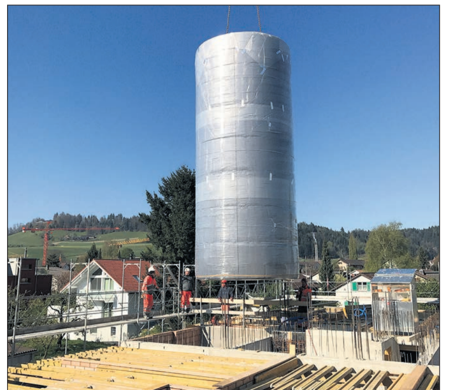
Einbau des Solarspeichers auf der Baustelle.
