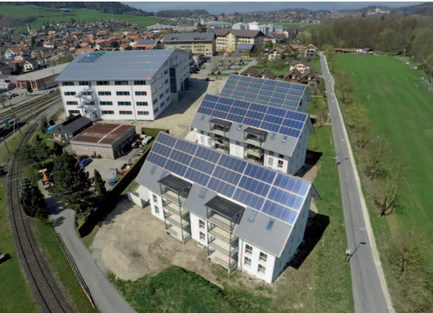
Die drei Mehrfamilienhäuser im Solarpark in Oberburg BE werden zu 100% mit Sonnenenergie für Heizung und Warmwasser versorgt. Mit grossen Wasserspeichern lässt sich Wärmeenergie mit Abstand am günstigsten speichern – vor allem auch saisonal.
