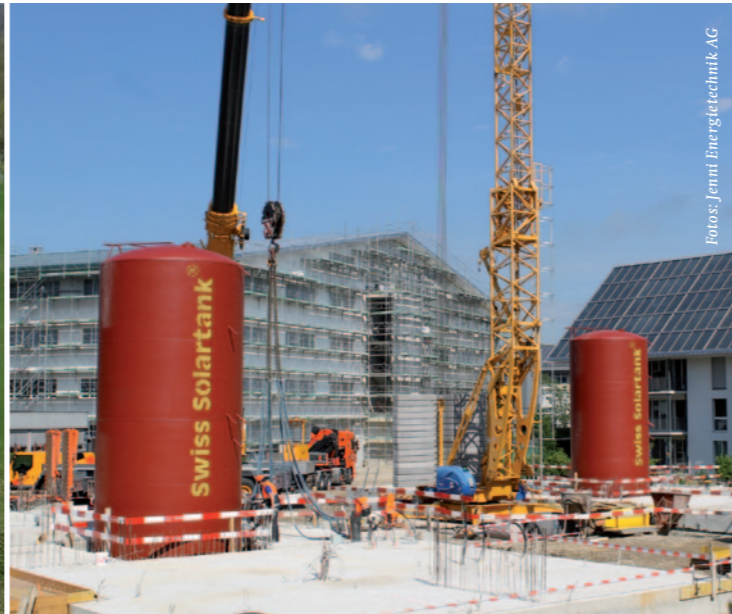
Die drei Mehrfamilienhäuser im Solarpark in Oberburg BE werden zu 100% mit Sonnenenergie für Heizung und Warmwasser versorgt. Mit grossen Wasserspeichern lässt sich Wärmeenergie mit Abstand am günstigsten speichern – vor allem auch saisonal.
