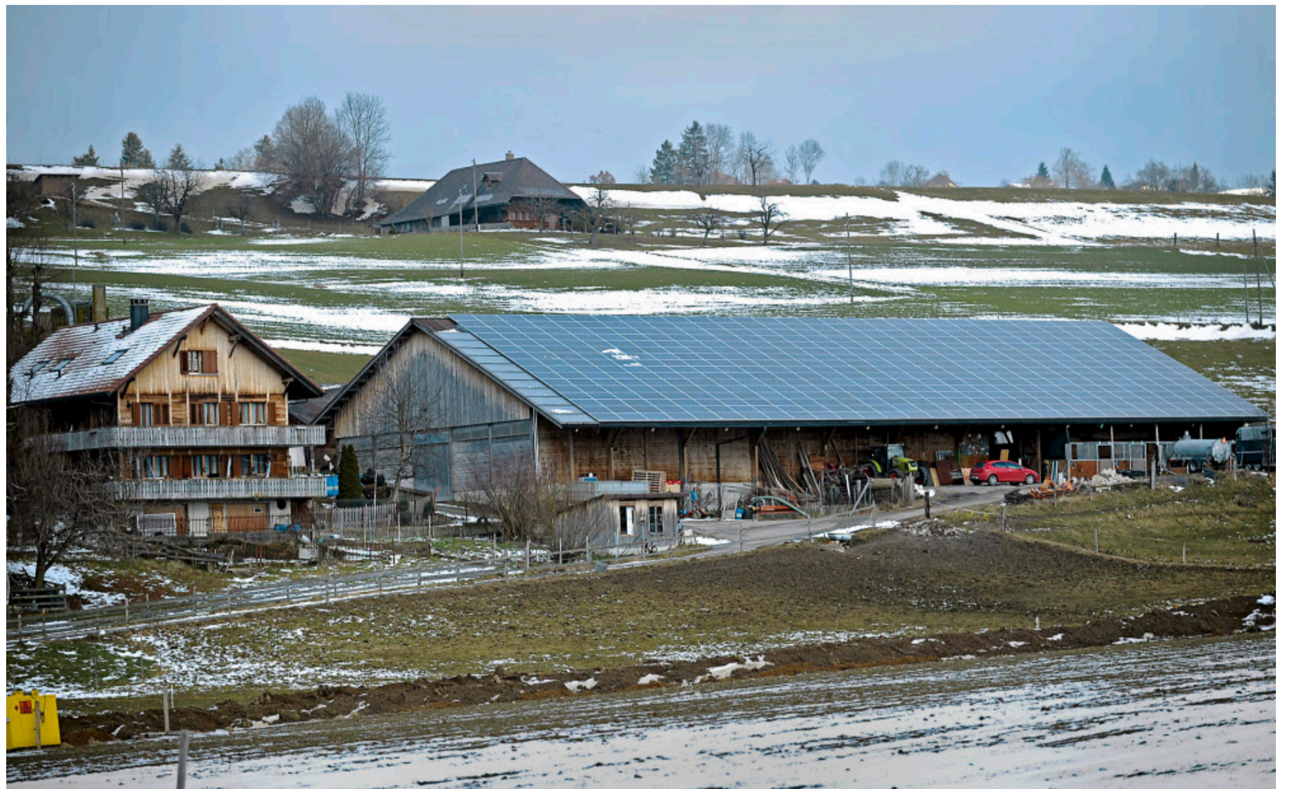
Der Löhlihof in Sumiswald: Die letztes Jahr installierte Fotovoltaikanlage funktioniert auch in wirtschaftlicher Hinsicht, so Energiefachmann Anton Kuchler.
