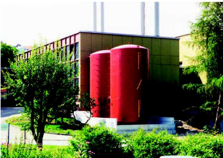
Zentralspeicher Nahwärmenetz (in Bau)
