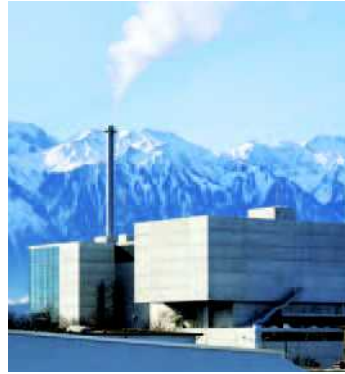
KVA Thun – ein modernes Kraftwerk
