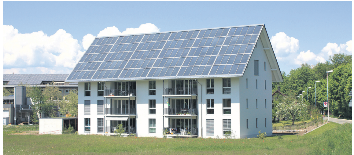
Mehrfamilienhaus in Oberburg, 100 Prozent solarbeheizt.
