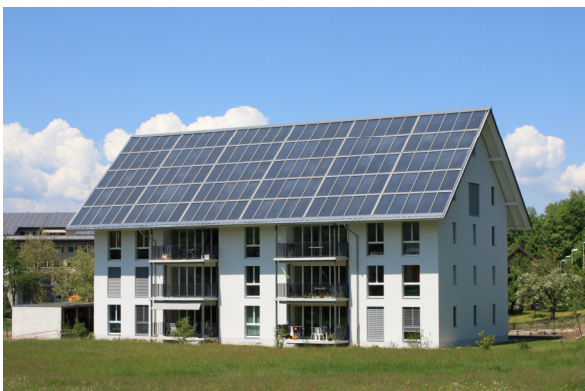
100% solar beheiztes Mehrfamilienhaus, Oberburg
