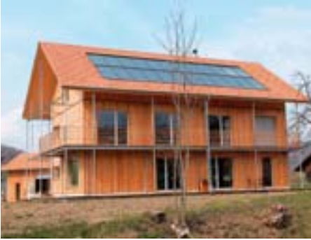
Weitgehend solarbeheiztes Niedrigenergiehaus in Heimiswil
