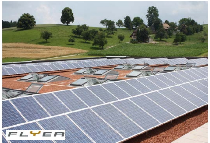
Industriegebäude, Huttwil (Biketec AG)
