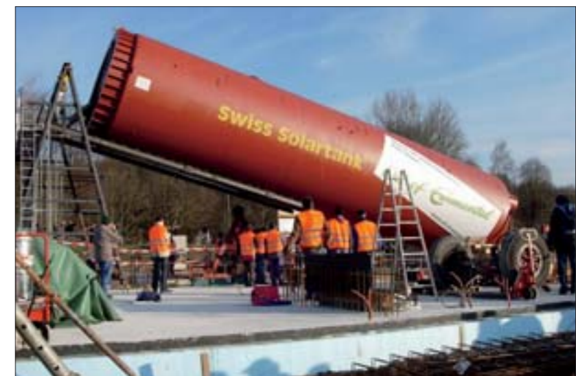
Mit den Füßen zuerst: Beim ersten Schritt des Aufstellens hievt die Helfer den Boden des 15 t schweren Stahlkolosses hoch, um die Kippe zu montieren.
